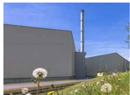
Abb.: Abgaskamin Wärmebehandlung 1
