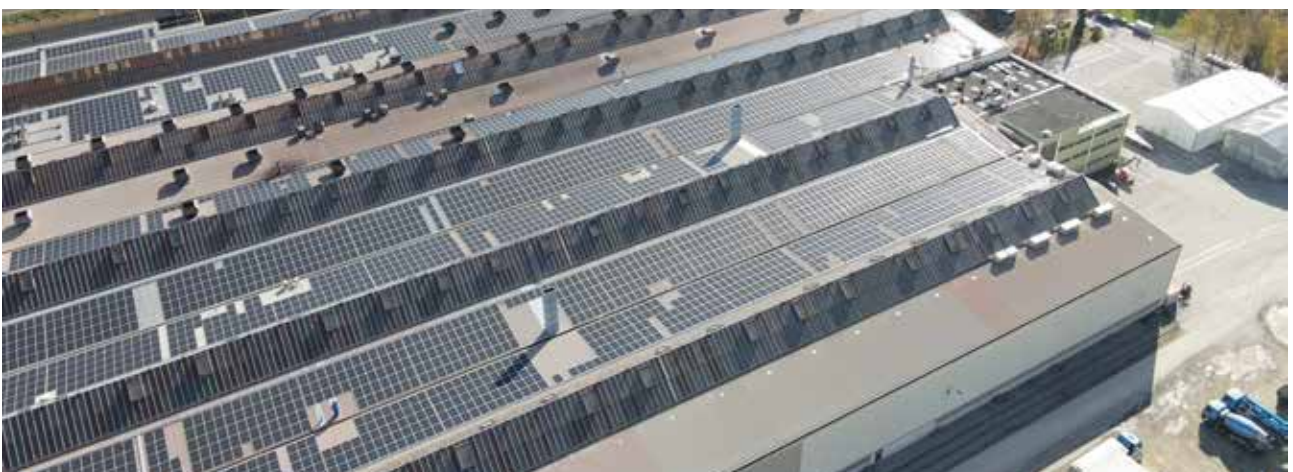
Abb.: PV-Anlage am Nahtlosrohrwalzwerk-Hallendach
