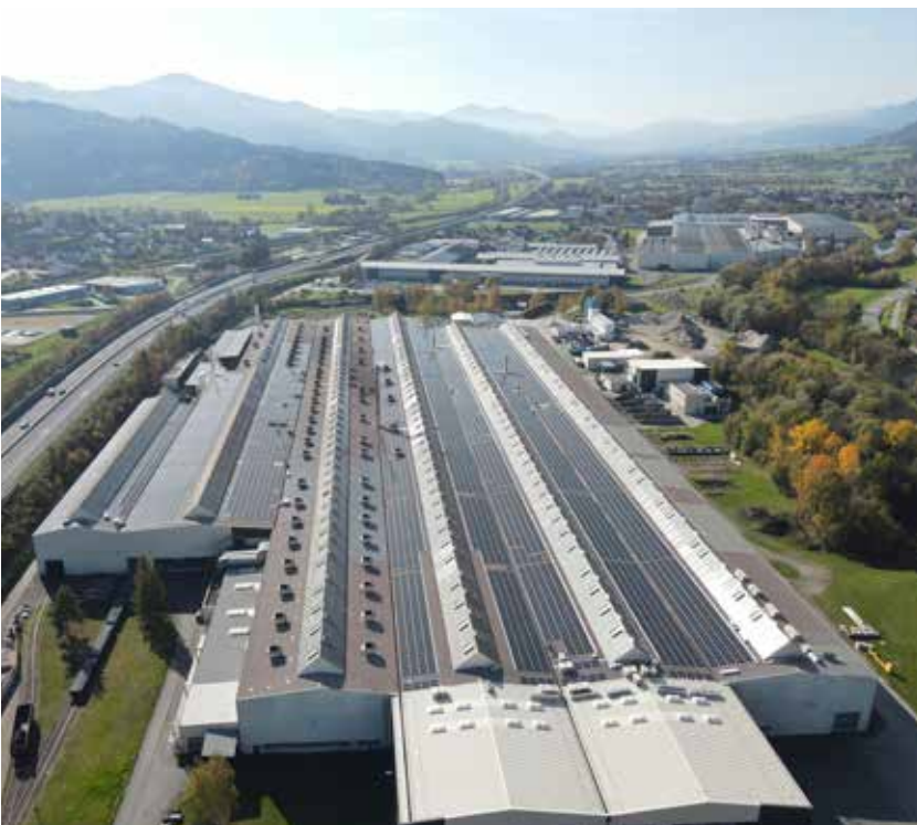
Abb.: PV-Anlage am NRW-Hallendach
