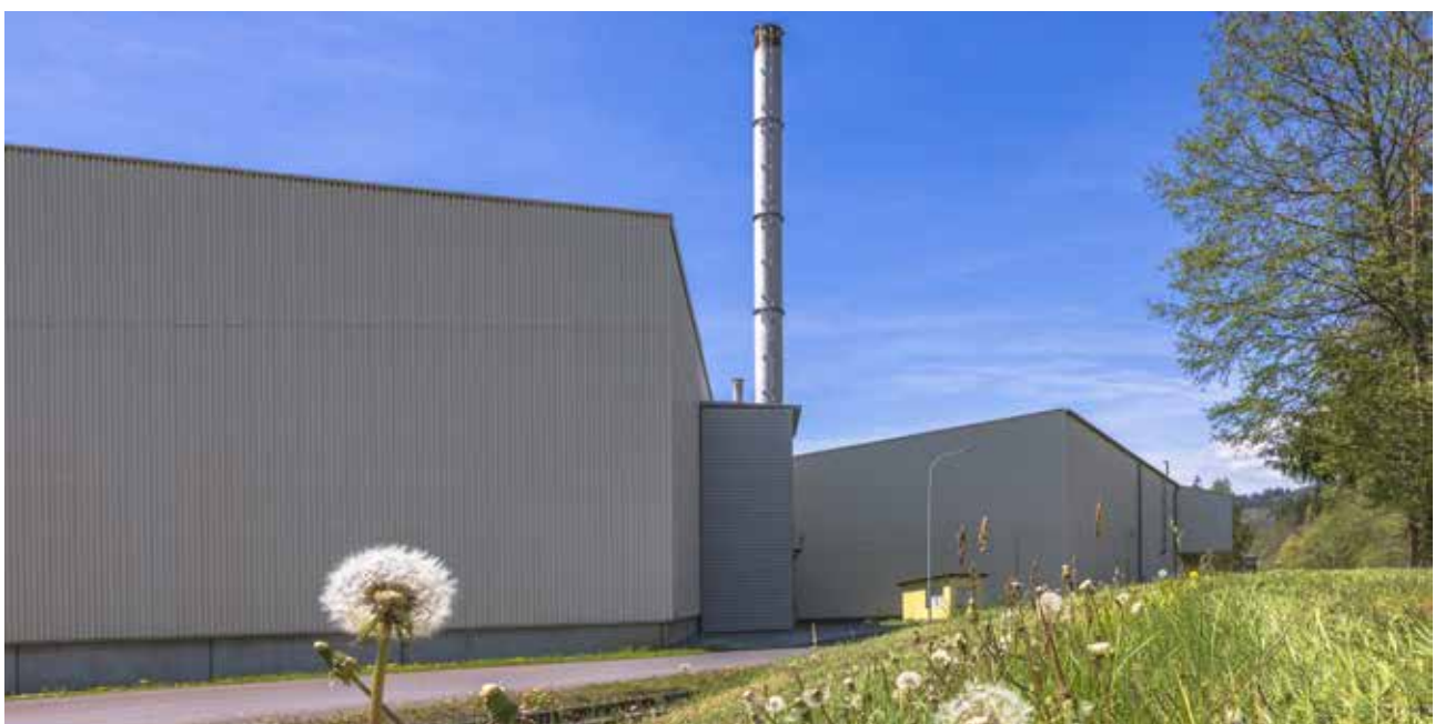
Abb.: Abgaskamin Wärmebehandlung 1
