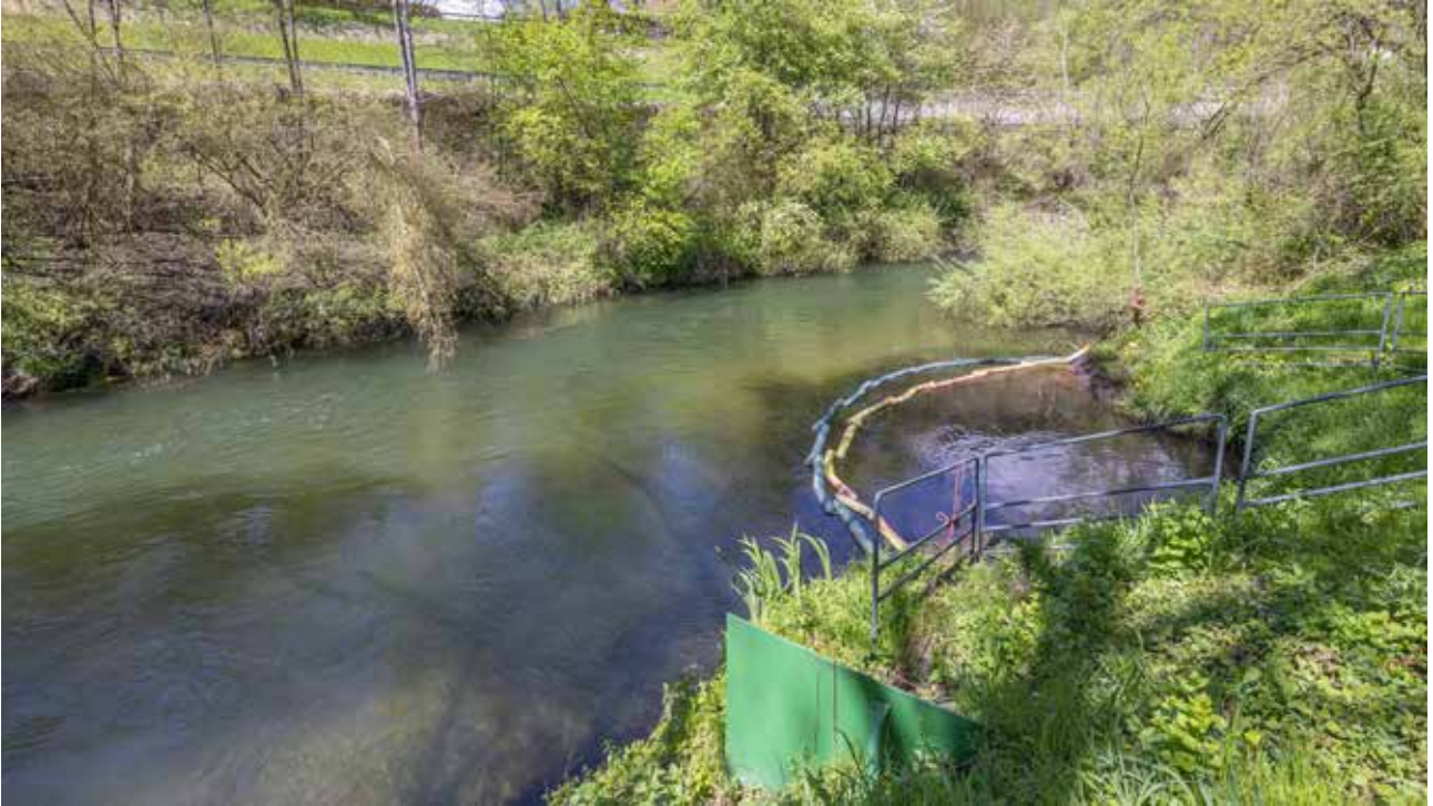
Abb.: Ölsperre bei Einleitstelle in Vorfluter
