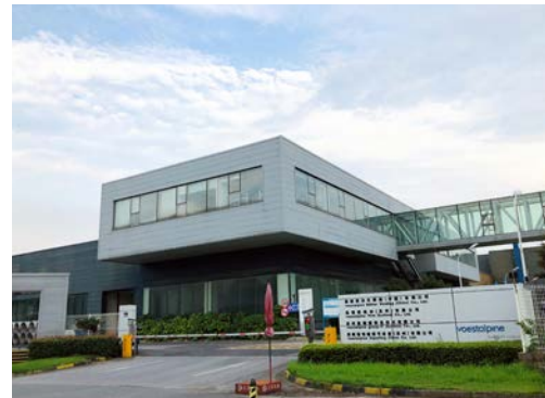
CAMPUS CHINA Weichen-, Signaling- und Gleisanlagen
