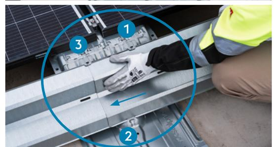
Die iFIX S Deflectoren so verschieben, dass sie am Reihenende 40 bis 60 mm von der Kante des iFIX S Verbinders enden.
