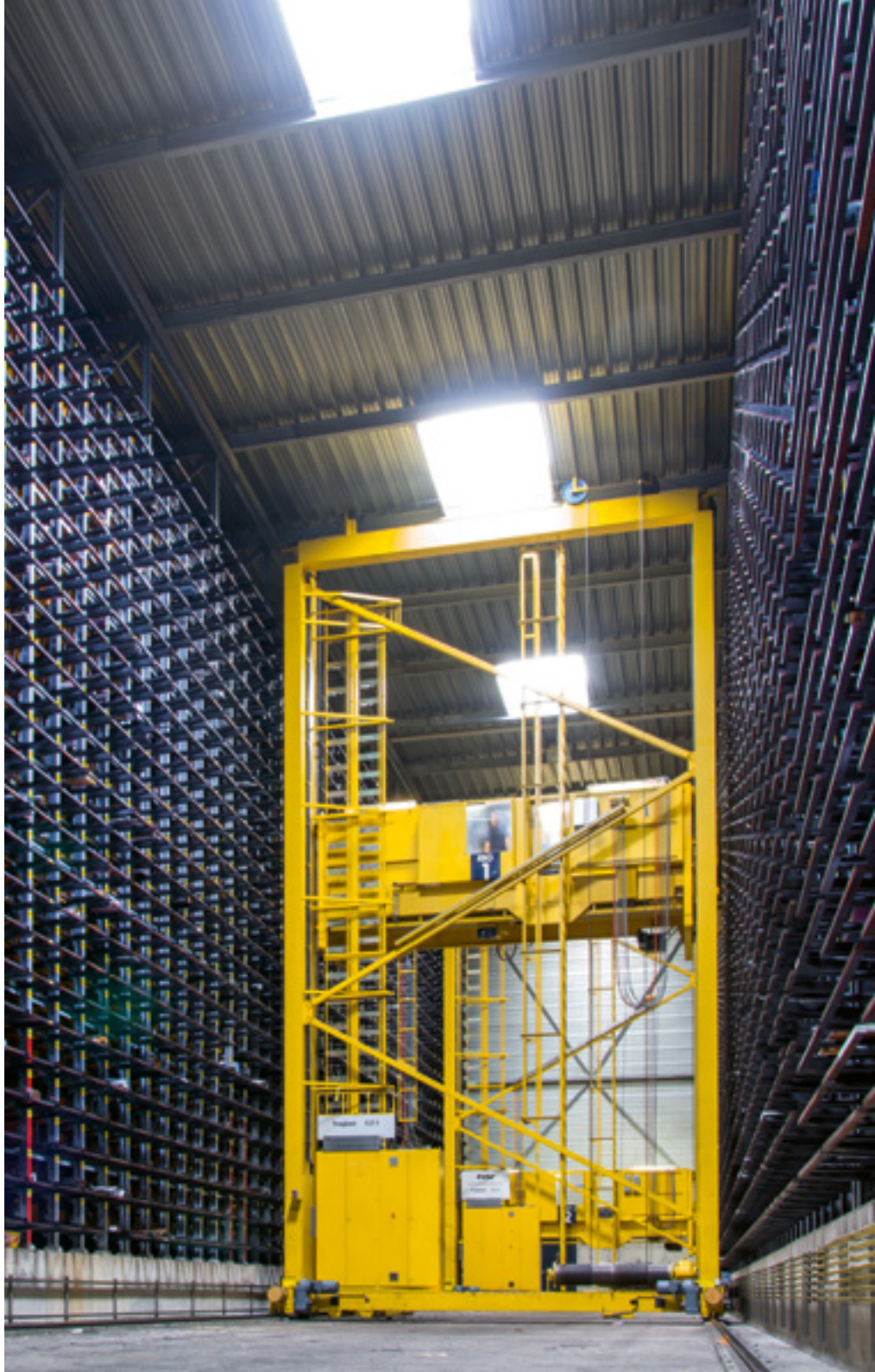
L'entrepôt à hauts rayonnages à Wallisellen
