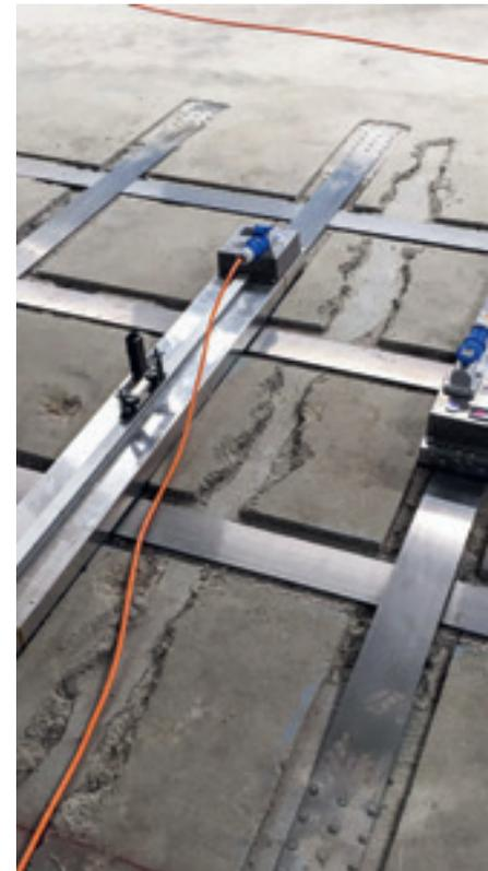
Le système re-plate pour renforcer un plafond (à gauche) et lors de l'activation par émetteur infrarouge (à droite).
