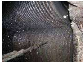
Aplicación de chapisco
