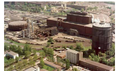
LD-Stahlwerk 3 am Standort Linz 1990.
