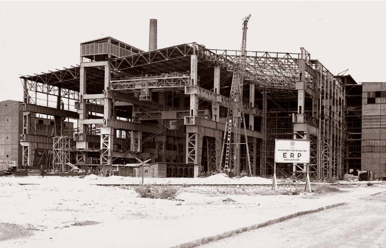
LD-Stahlwerk 1 der VÖEST in der Bauphase.
